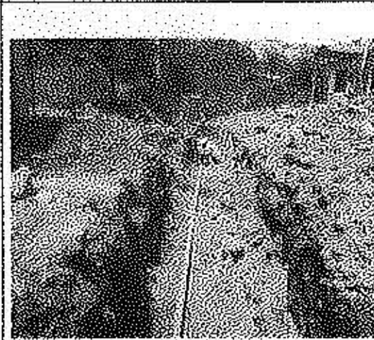
Enero - 2018. Excavación para extensión de red de agua potable calle: Martín Ortega entre 4 de Diciembre y Eloy Chicaiza.
