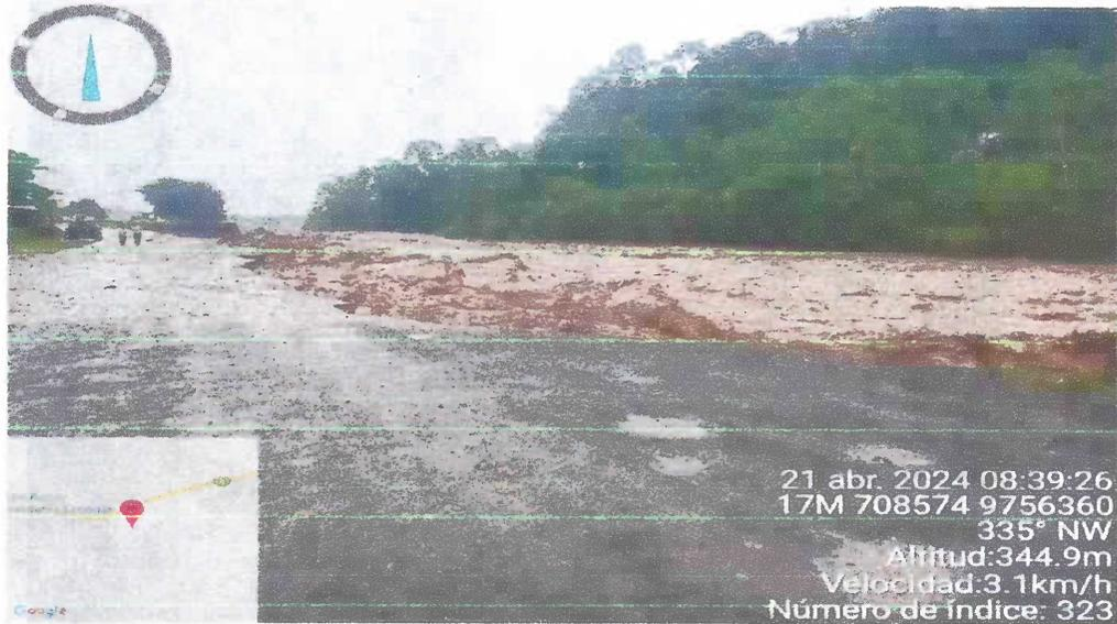
En la siguiente imagen podemos observar lo que ocasiono el aluvión en el recinto Chalguayacu tapando las alcantarillas y derramando todo el material pétreo en la calzada de la vía.
